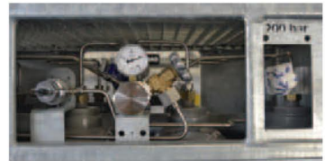
Válvula reductora integrada de un bloque de botellas de 300 bar con conexión de suministro de 200 bar
